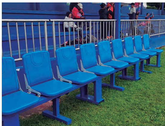
Se instalaron bancas para atletas en el campo de fútbol del Complejo Deportivo de Quetzaltenango
