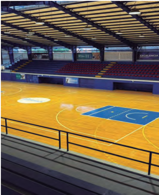
Montaje de cubierta y compra para instalación de luminarias en el Gimnasio Polideportivo de Chiquimula
