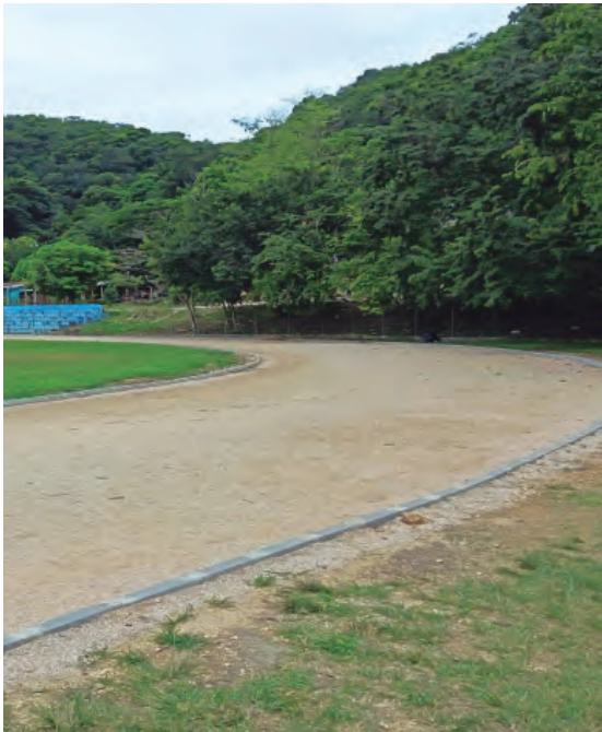
Mantenimiento de la Pista de Atletismo en el Complejo Deportivo de Santa Elena, Petén
