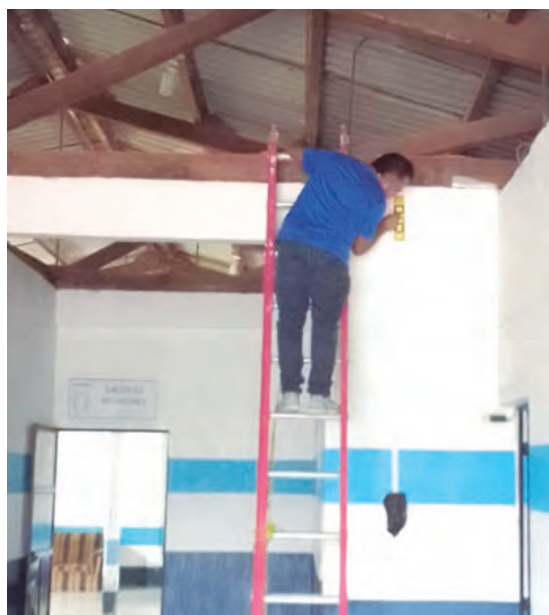
Cableado estructurado de Red en instalaciones deportivas
