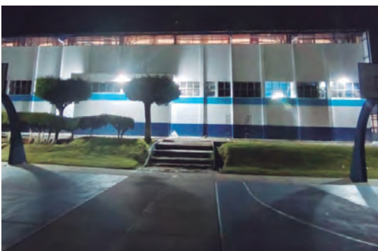
Trabajos de mantenimiento preventivo específico de sistemas de iluminación en instalaciones deportivas de CDAG / Iluminación Totonicapán
