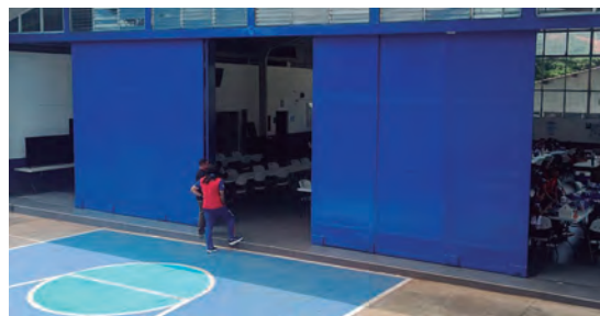
Se reparó y aplicó pintura a portones de comedor del albergue Ramiro de León Carpio
