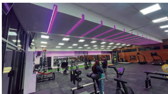
Instalación de cielo falso CENAD zona 13 Guatemala
