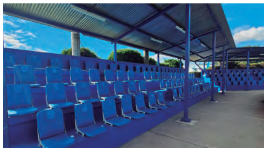
Se instalaron butacas nuevas en Quetzaltenango
