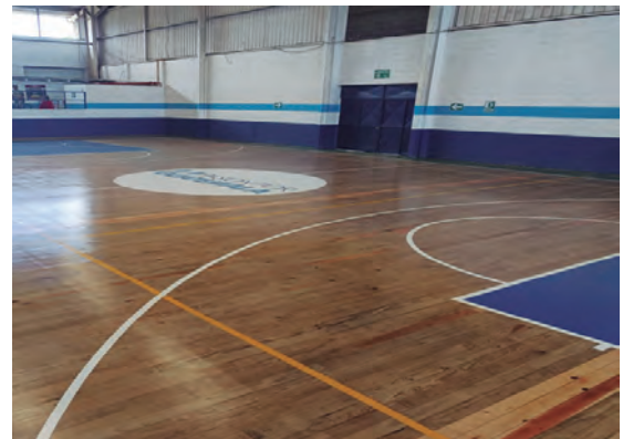
Trabajos de mantenimiento preventivo específico en marcaje y pintura de cancha en instalaciones deportivas de CDAG / Mantenimiento Duela Villa Deportiva Huehuetenango
