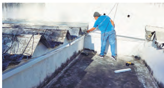
Cableado estructurado de Red en instalaciones deportivas
