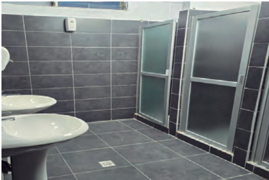
Mantenimiento e instalación de pisos para habitaciones, sanitarios y duchas de hombres en el Albergue del Complejo Deportivo de Jalapa
