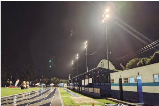
Reparación de acometida e iluminación en la Pista de Atletismo del Complejo Deportivo de Quetzaltenango
