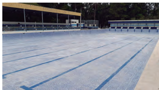
Mantenimiento y reparación del sistema de bombeo y del vaso de la piscina del Complejo Deportivo de Jalapa
