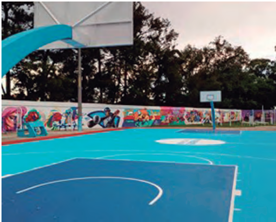
Aplicación de pintura y mantenimiento correctivo en la reja perimetral en las canchas de la doce avenida Ciudad Deportiva, Zona 5, Guatemala
