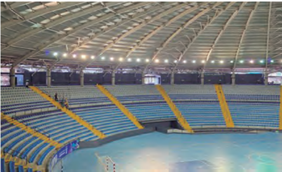
Mantenimiento correctivo menor y emergente en el sistema de iluminación en el Domo Polideportivo, zona 13
