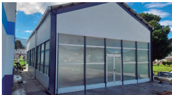
Plataforma calentamiento para levantamiento de pesas Totonicapán
