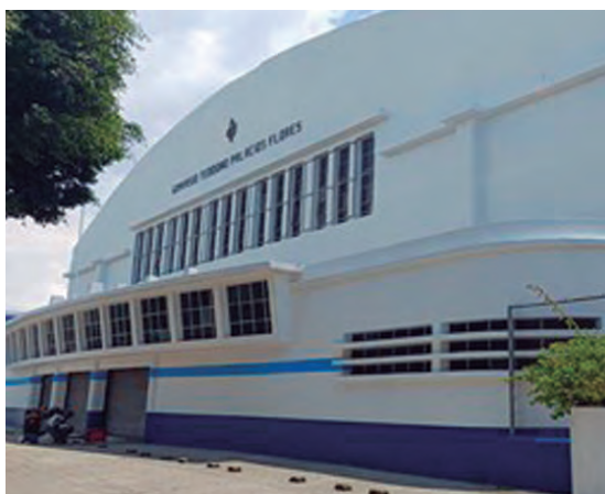
Mantenimiento correctivo a pintura de paredes exteriores e interiores del Gimnasio Nacional Teodoro Palacios Flores, zona 5
