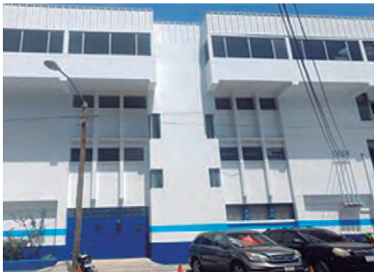
Mantenimiento a paredes de fachada exteriores del edificio de Cronistas Deportivos, Ciudad de los Deportes, zona 5, Guatemala
