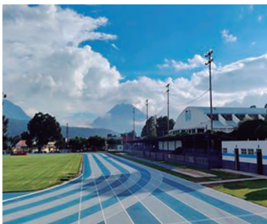
Mantenimiento y reparación de la pista de Atletismo del Complejo Deportivo de Quetzaltenango
