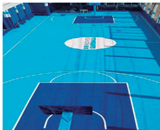
Mantenimiento correctivo, aplicación de pintura y marcaje de la cancha de baloncesto, Chiquimula
