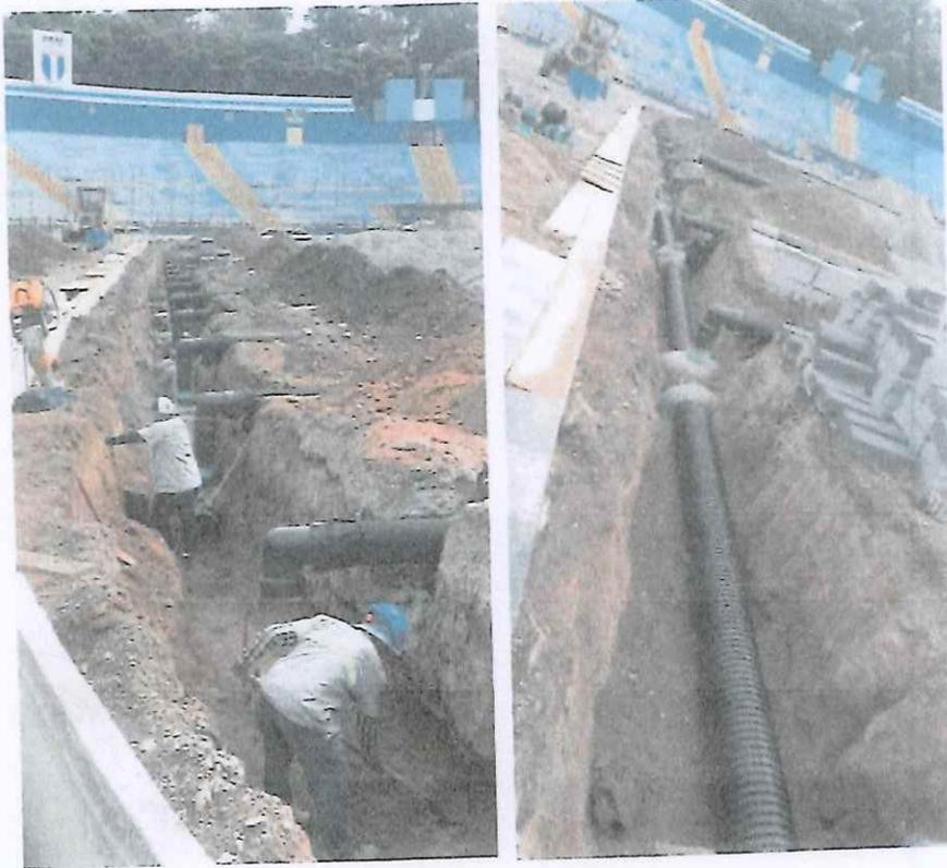
Conexion de tubería de 8" a tubería principal de 12" por medio de codos a 90°, se aplicó concreto en las uniones sobre tubería principal para estabilizar el sistema de drenaje y evitar desajustes posteriores por compactación.
