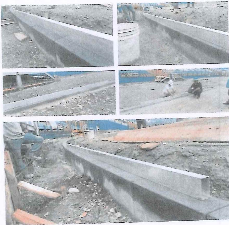
Instalación de bordillo y pase de regía de aluminio de 4 metros de largo para rectificar superficies planas
