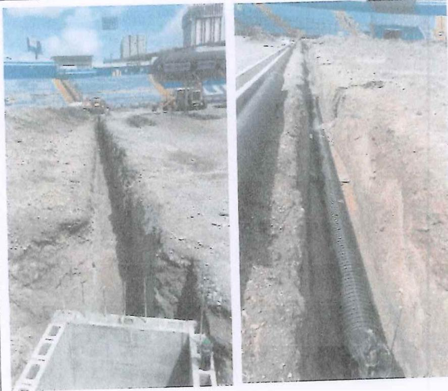
Excavación y compactación de base para la instalación de tubería de 12 pulgadas que recibe tubería de 8 pulgadas y conecta con cajas recolectoras.
