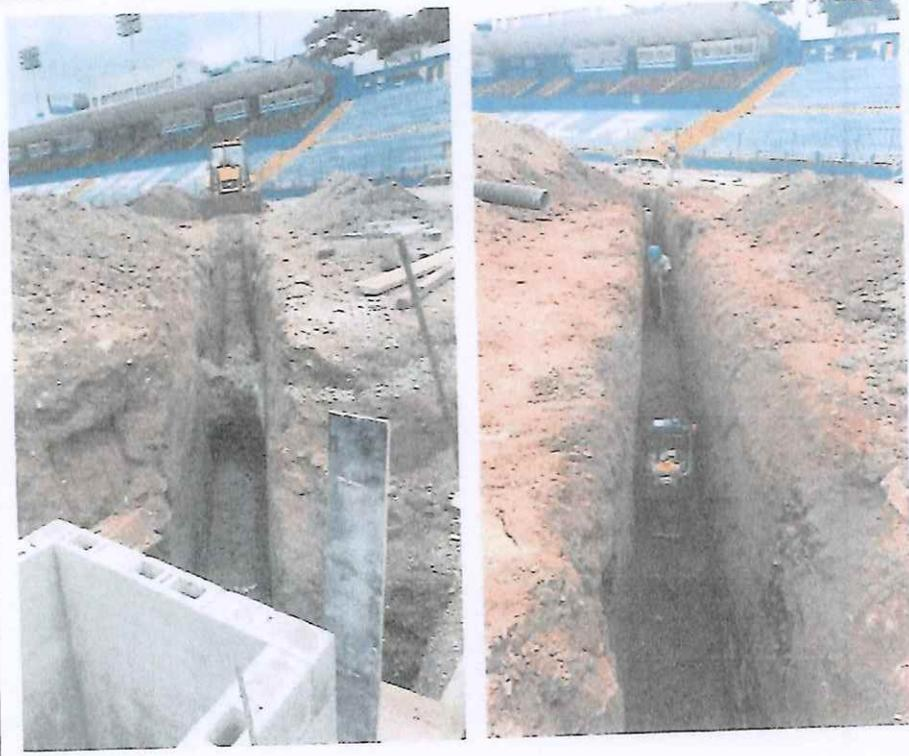
Excavación y compactación de base para la instalación de tubería de 12 pulgadas que recibe tubería de 8 pulgadas y conecta con cajas recolectoras.
