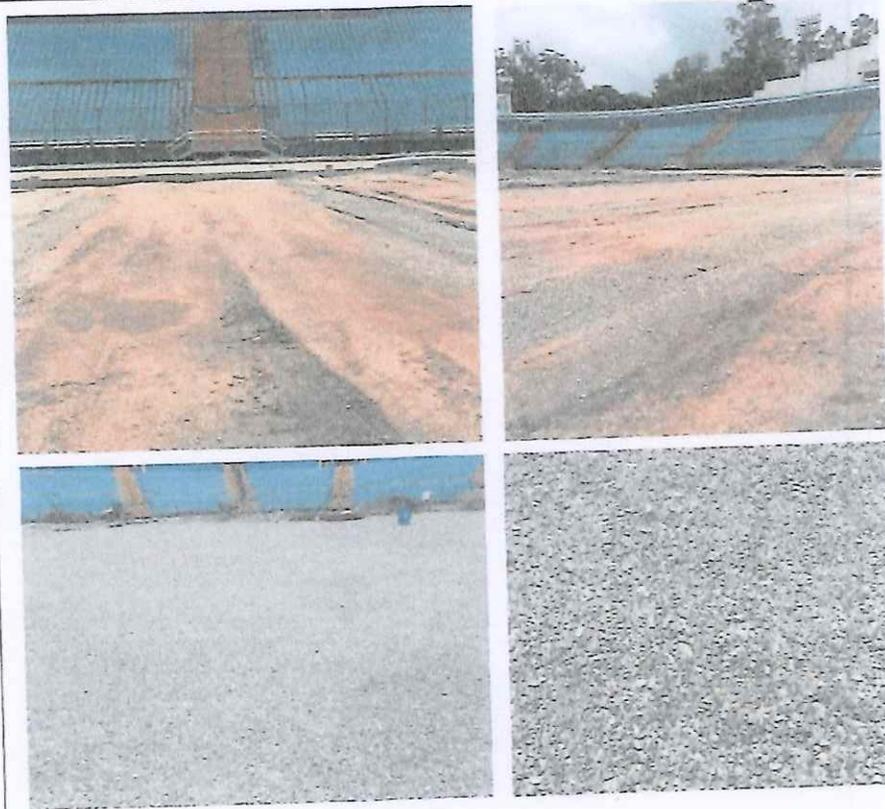
Posterior a la instalación de la tubería de 8 pulgadas, se procedió a enterrar la tubería, se verificó que la base de piedrín estuviera libre de material contaminante.
