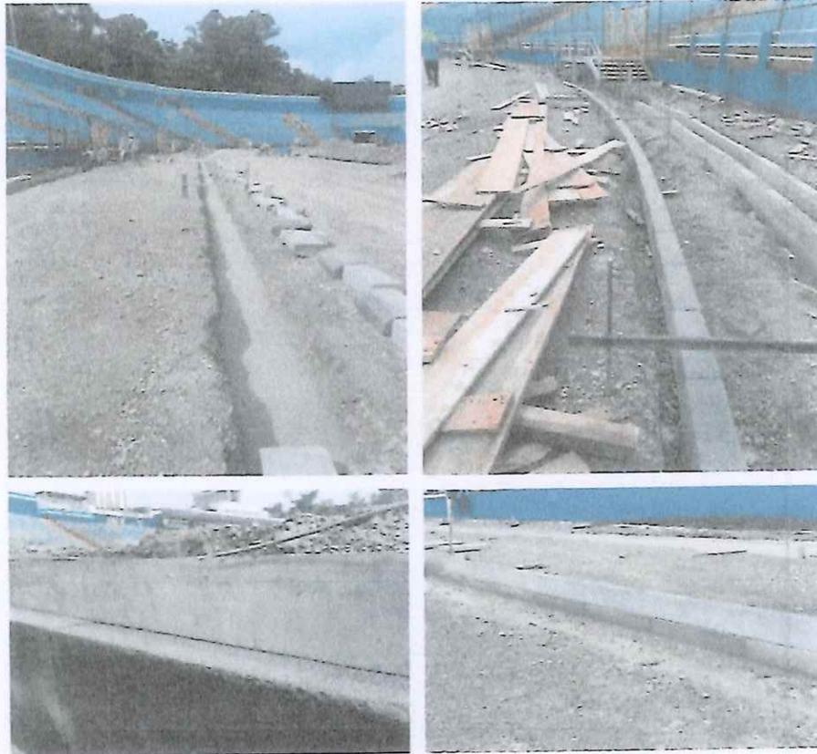
Instalación de bordillo y paso de regla de aluminio de 4 metros de largo para rectificar superficies planas
