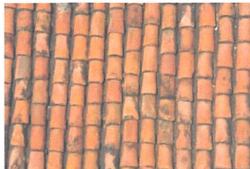
Figura 10. Cubierta de Teja
